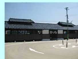
越中八尾駅前広場整備
