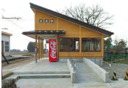
図 1-2-5 改修された大庄駅
