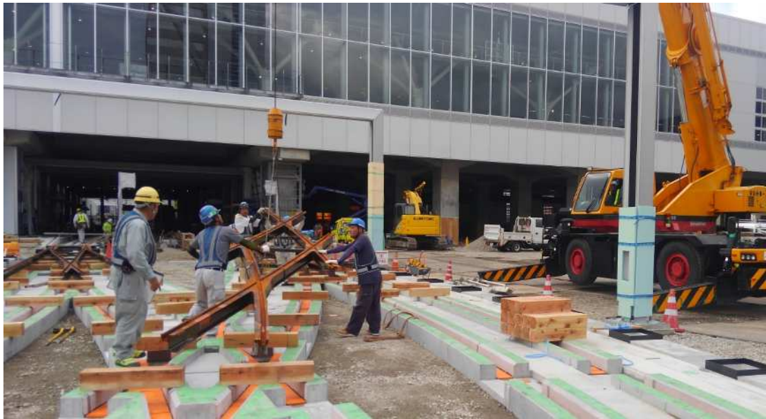
工事進捗状況（北口駅前広場部におけるレール搬入 R元年.9.24 時点）
