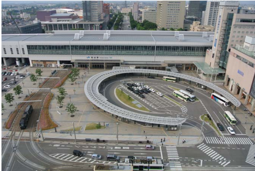
新幹線駅舎と南口駅前広場
