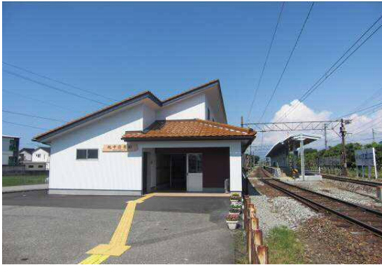
越中荏原駅 H21：駅舎改修
