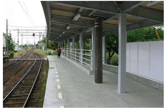
東新庄駅 H20：ホーム・上屋改修
