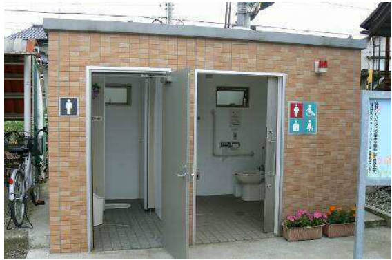
越中三郷駅 H22：トイレ設置
