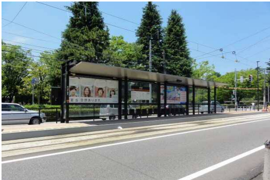
市内軌道線 富山大学前 平成 23 年度整備
