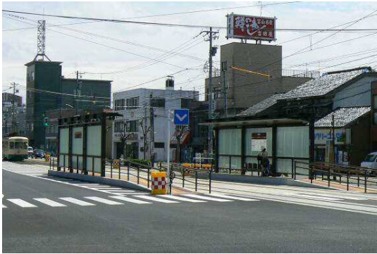
市内軌道線 安野屋 平成 23 年度整備
