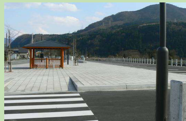
笹津駅前広場 外観
