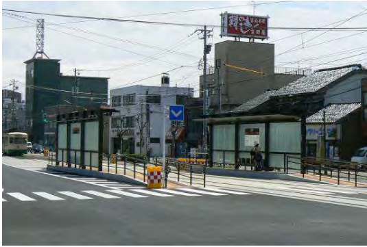
市内軌道線 安野屋 平成 23 年度整備
