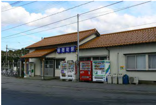
地鉄本線 稲荷町駅 H19：駅舎改修
