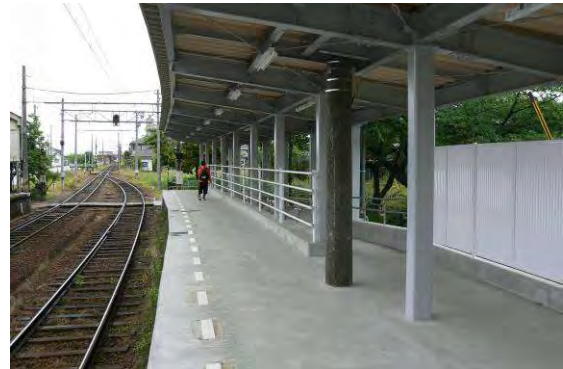
地鉄本線 東新庄駅 H20：ホーム・上屋改修
