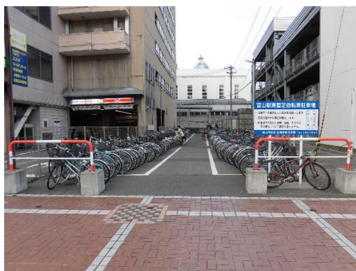
【富山駅東暫定自転車駐車場】
