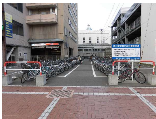
【富山駅東暫定自転車駐車場】
