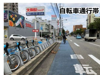
【主要地方道富山港線】
