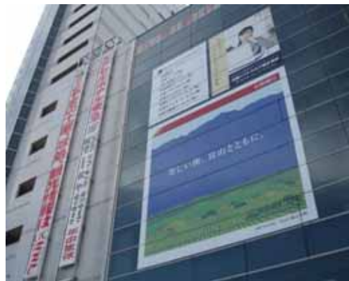
【建物ファサード面を占める広告】
