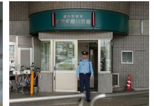
小田急和泉多摩川駅前高架下に位置する和泉多摩川交番
