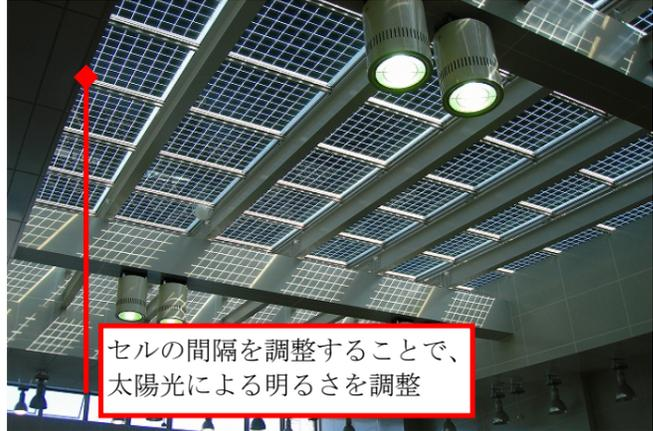
セルの間隔を調整することで、太陽光による明るさを調整
