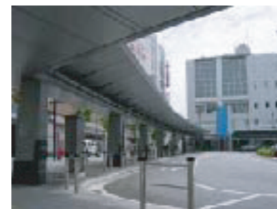
駅と連続したシェルター(伊丹駅)
