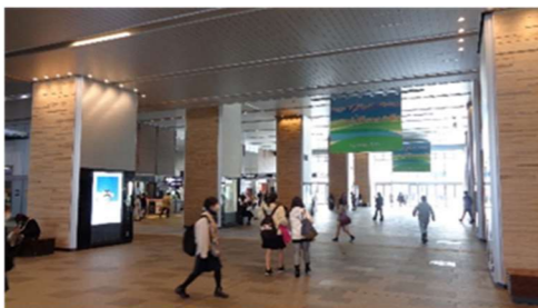
令和2年3月 南北自由通路完成 令和2年12月 東西自由通路完成
