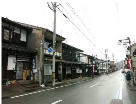
施設③（上新町）メイン通りに面している
