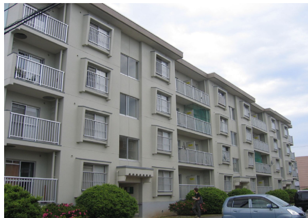
高原町団地4号棟(景観改善工事)
