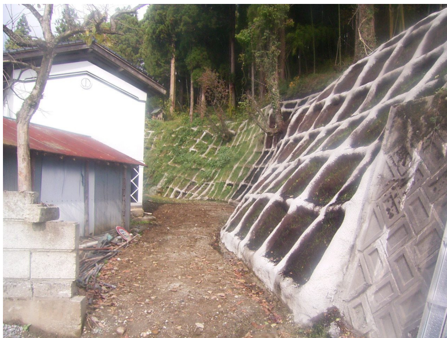
茗ヶ原地区（急傾斜地崩壊防止対策事業）
