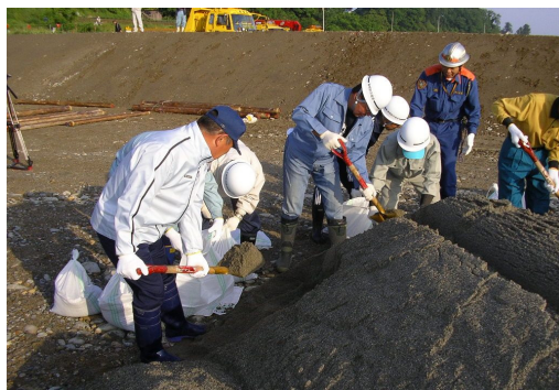
改良積み土のう工法の様子
