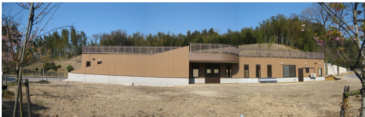
整備実績（ファミリーパーク里山生態園：H20年度施工）
