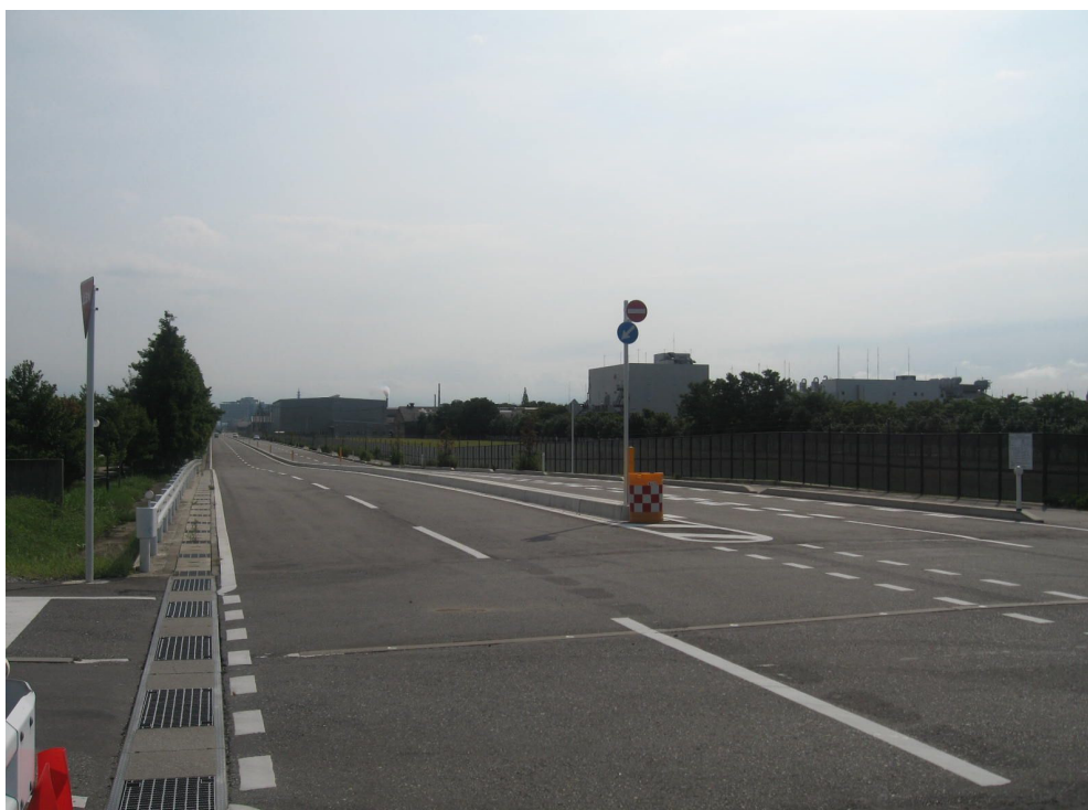
整備実績(都市計画道路牛島城川原線:H20年度完成)
