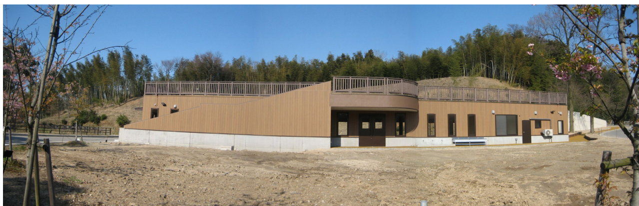
整備実績（ファミリーパーク里山生態園：H21 年度施工）
