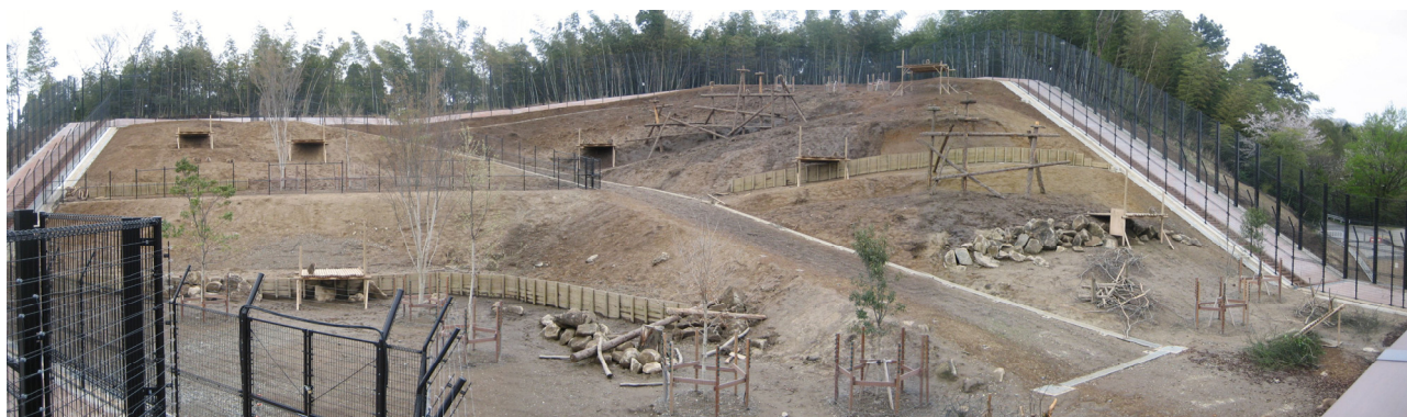
整備実績 (ファミリーパーク里山生態園 : H22 年度施工)
