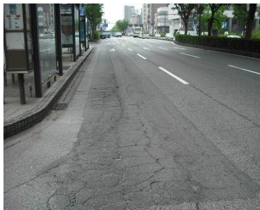
道路舗装の老朽化
