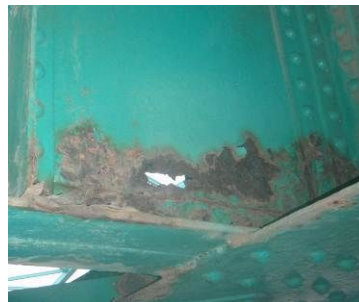
橋梁の老朽化
