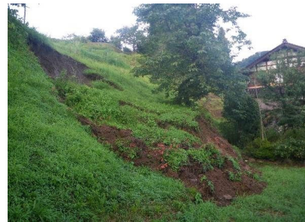
八尾竹ノ内尾久地内
