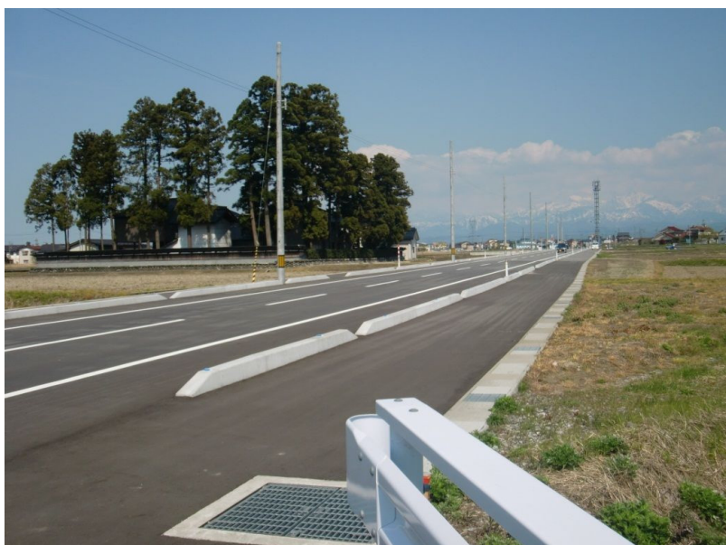
整備実績(市道町村線)
