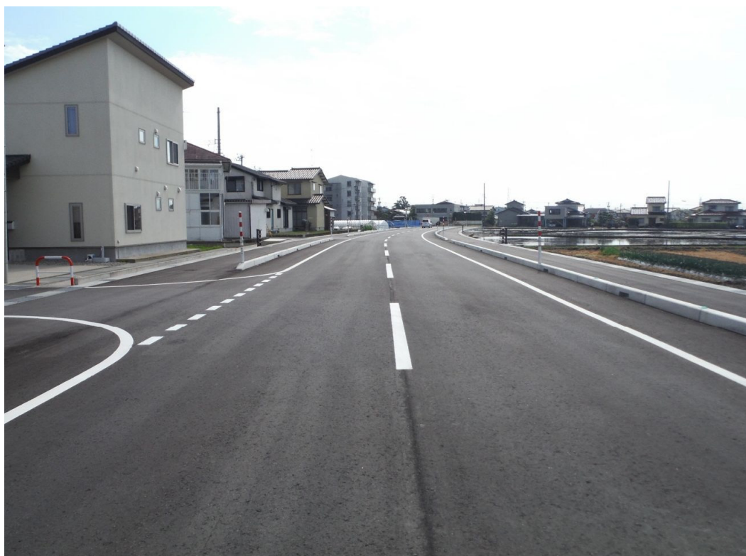
整備実績(都市計画道路経堂中間島線 改良事業)
