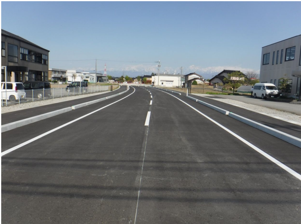
整備実績(都市計画道路西荒屋黒崎線 改良事業)
