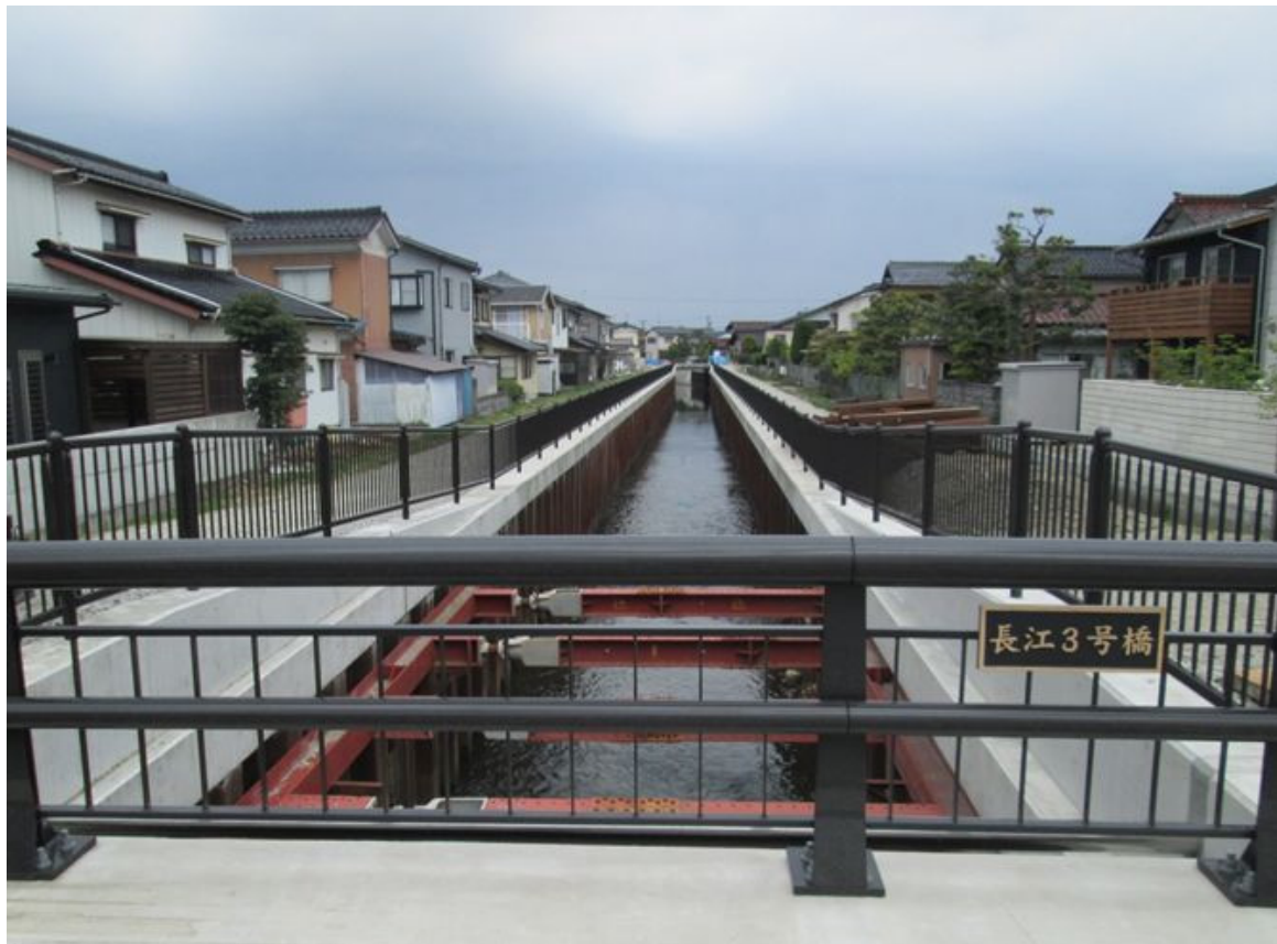
整備実績（都市基盤河川改修事業 宮路川）
