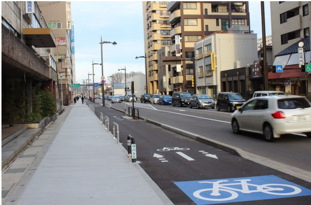
整備実績(都市計画道路富山駅西線 電線類地中化事業)
