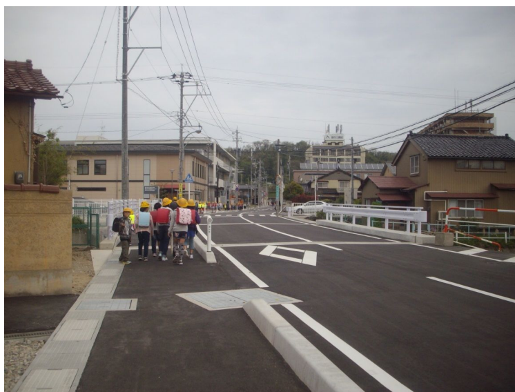
五福大工町線(藤子橋) H27年度完成
