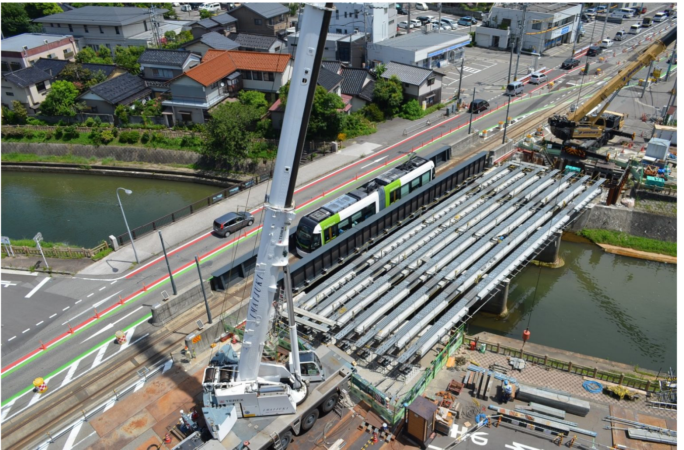
八田橋 [プレビーム桁架設状況]
