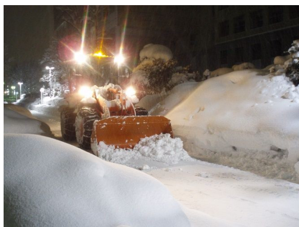
積雪時の道路環境を守る機械除排雪
