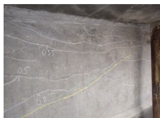
ひび割れの進展
