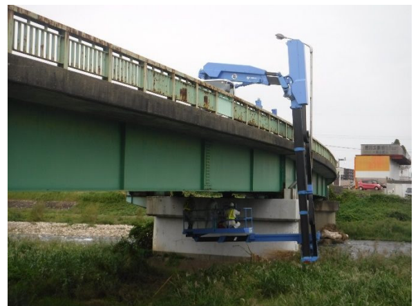
橋梁の点検状況
