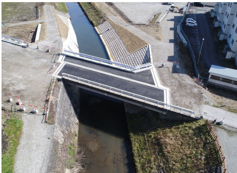
【八ヶ山石坂線(石坂橋) H30年度完成】
