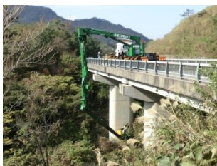
橋梁点検車による点検
