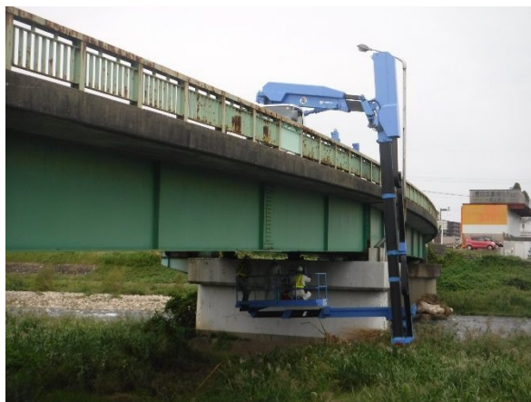
橋梁の点検状況
