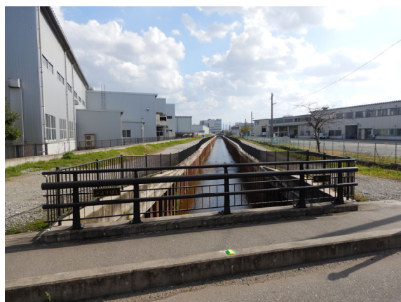
整備実績 (準用河川改修事業 中川)
