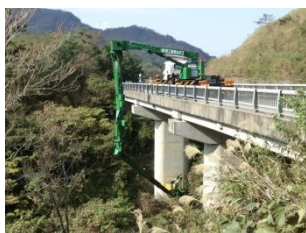
橋梁点検車による点検
