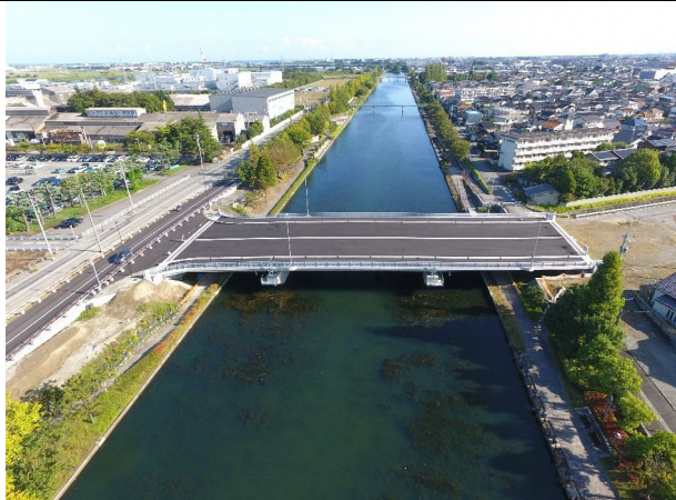
【(都)下新西町上赤江線 大島橋上部工】
