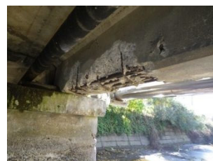
深刻な断面欠損
