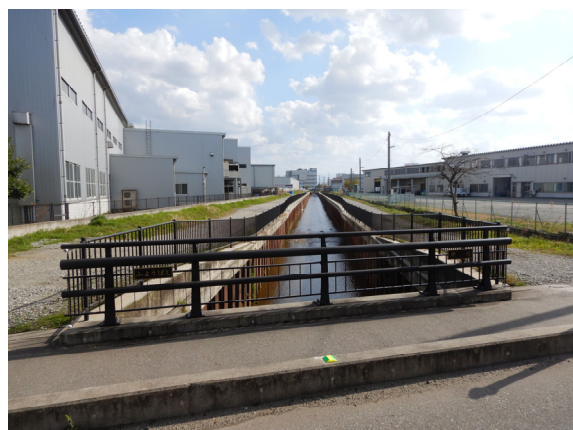
整備実績（準用河川改修事業 中川）
