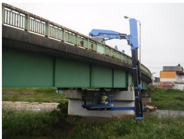
橋梁の点検状況
