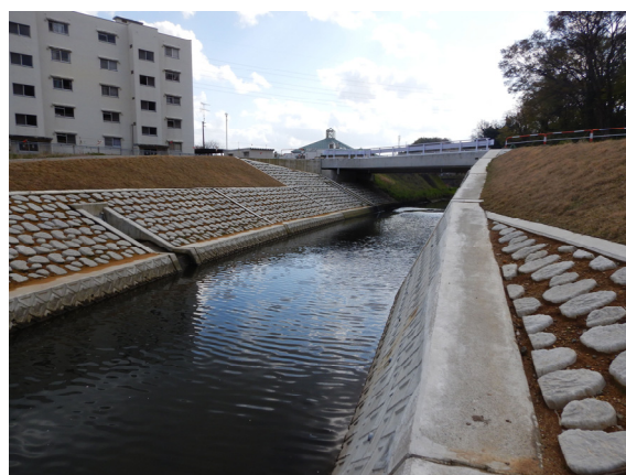
整備実績（都市基盤河川改修事業 馬渡川）
