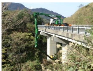
橋梁点検車による点検
