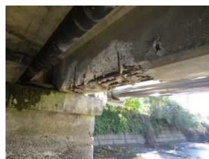
深刻な断面欠損
