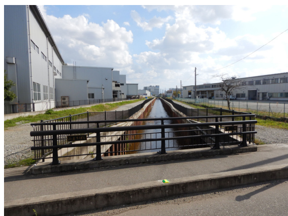
整備実績(準用河川改修事業 中川)
