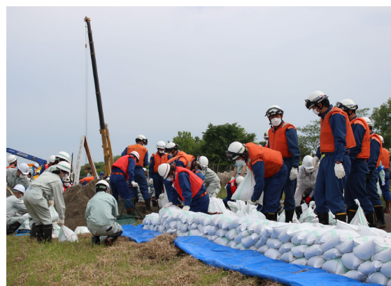
改良積み土のう工法
