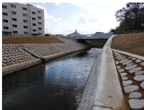
整備実績(都市基盤河川改修事業 馬渡川)
