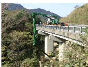
橋梁点検車による点検
