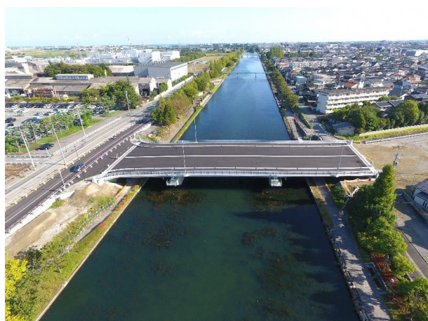
【(都)下新西町上赤江線 大島橋上部工】
