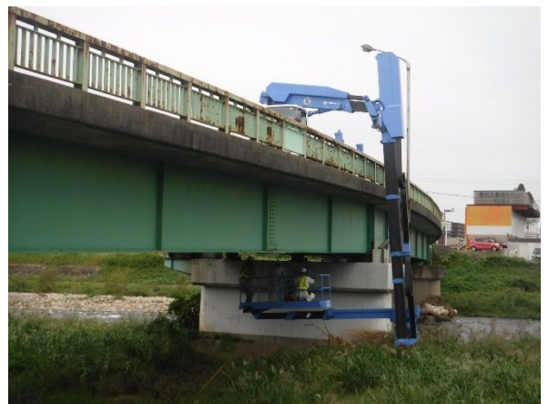
橋梁の点検状況
