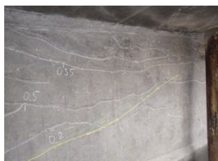
ひび割れの進展
