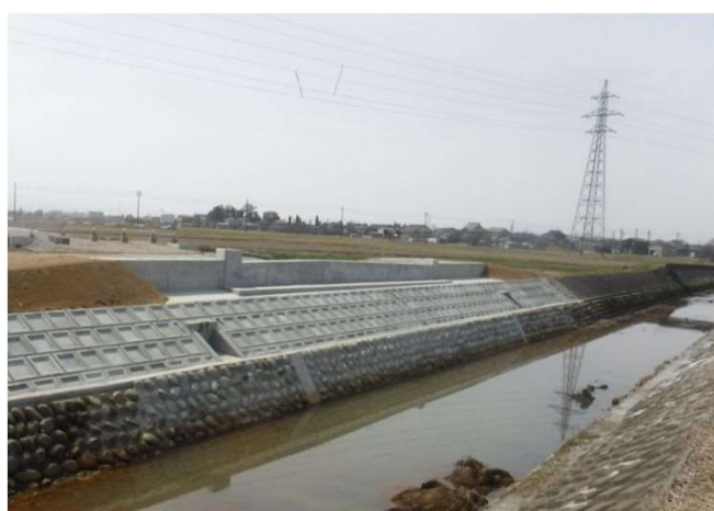
【市道水橋伊勢屋肘崎線橋梁下部工】
