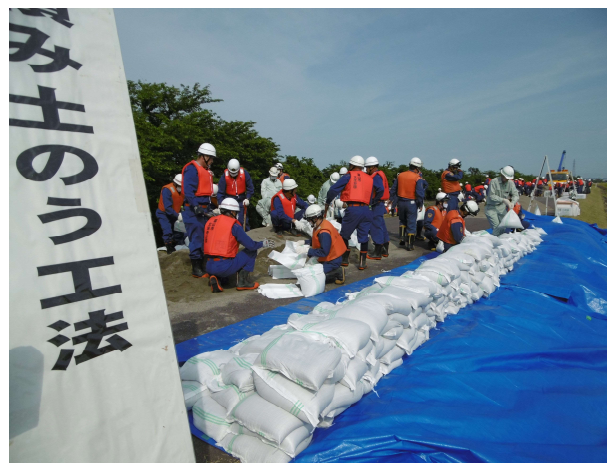
改良積み土のう工法
