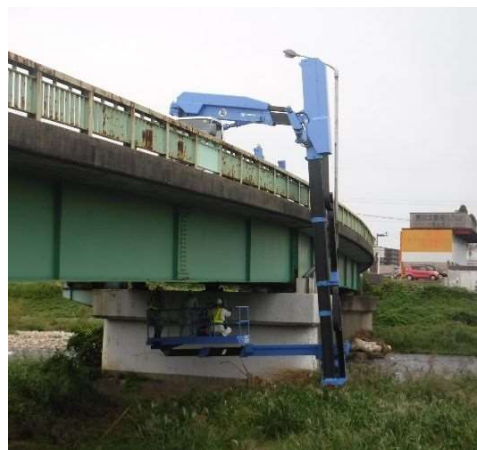
橋梁の点検状況
