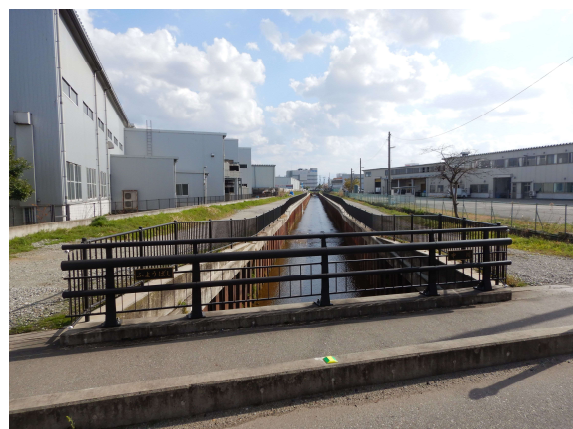
整備実績 (準用河川改修事業 中川)
