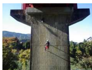
特殊高所作業による点検
