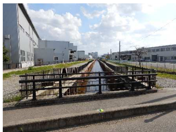
整備実績（準用河川改修事業 中川）
