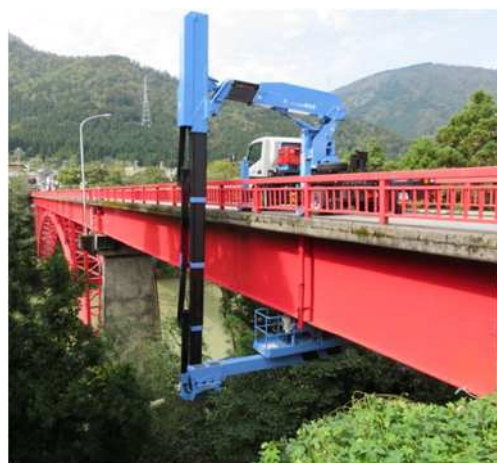
橋梁の点検状況
