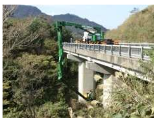
橋梁点検車による点検
