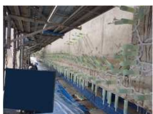
ひび割れ注入
