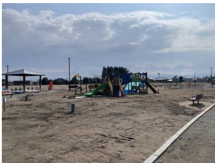
R6 山室二区公園整備状況
