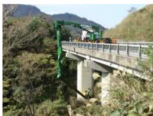
橋梁点検車による点検
