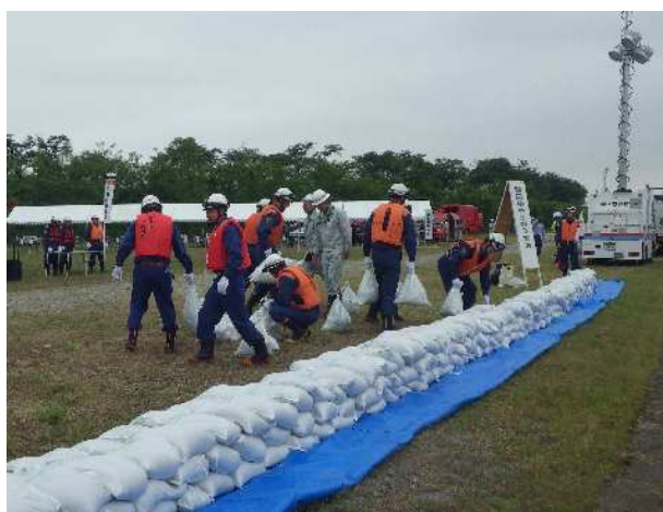
改良積み土のう工法
