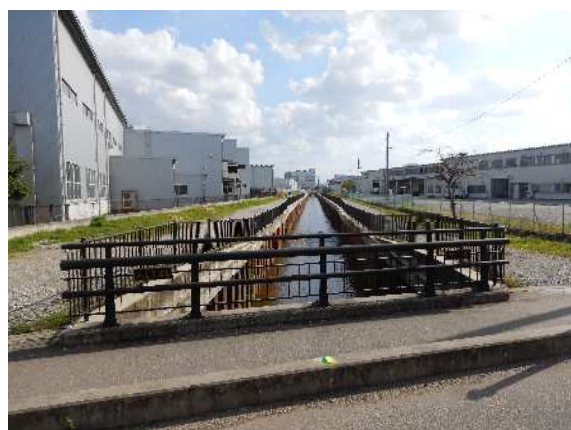
整備実績(準用河川改修事業 中川)
