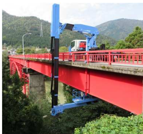
橋梁の点検状況
