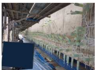
ひび割れ注入
