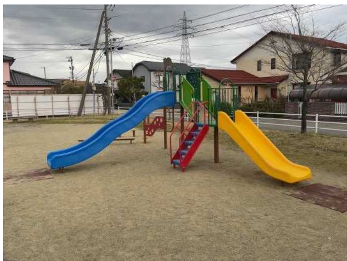
R6 砂子田若葉台団地公園 遊具更新 (公園施設長寿命化対策)
