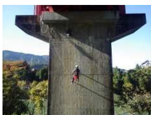
特殊高所作業による点検
