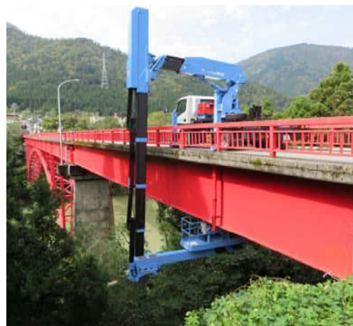
橋梁の点検状況
