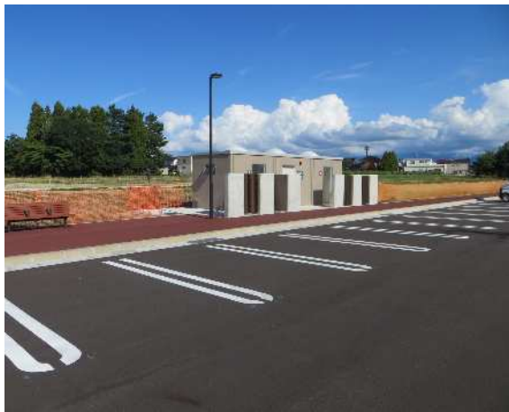
R7 山室二区公園整備状況
