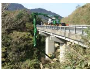
橋梁点検車による点検
