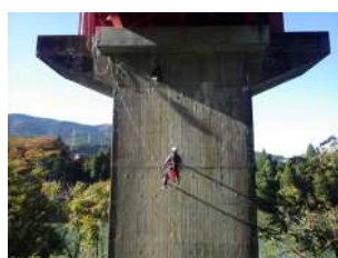
特殊高所作業による点検
