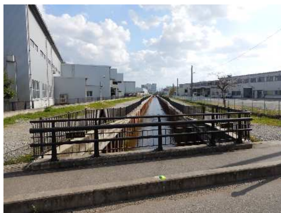
整備実績(準用河川改修事業 中川)
