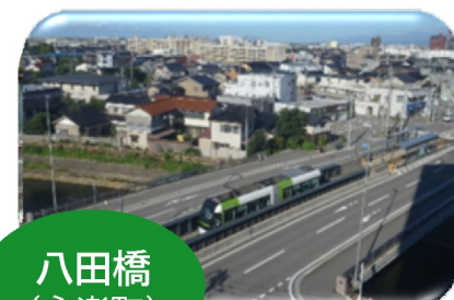
特殊な構造の橋 / ポ-外ラ-ンプビ-ム合成桁橋
