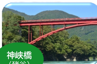
特殊な構造の橋 / 鋼ランガー橋
