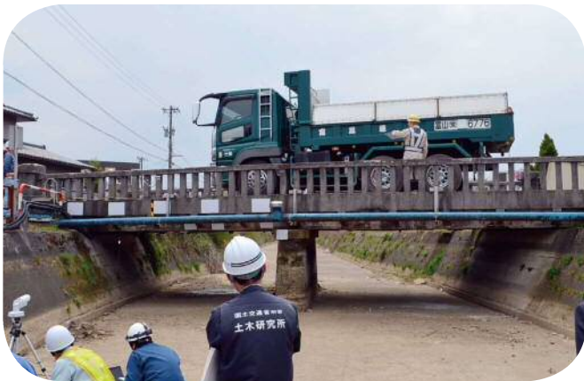
▲センサーの動作確認 (国立研究開発法人 土木研究所との実証実験)
