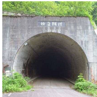
みょうがんずいどう 妙巖隧道 延長/260m 幅員 7.5m 所在地/山田数納地域
