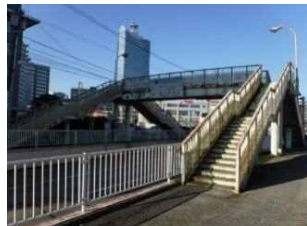
牛島本町横断歩道橋 延長/15.0m 幅員 1.9m 所在地/牛島新町地域
