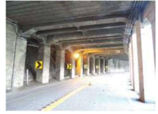
長良谷 4 号洞門 延長/28.8m 幅員 4.7m 所在地/庵谷地域
