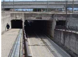
稲荷公園地下道 (東) 延長/13.6m 幅員 8.5m 所在地/綾田地域
