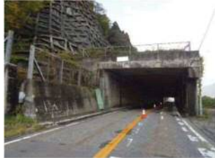
松ヶ谷洞門 延長/135.0m 幅員 8.5m 所在地/庵谷地域
