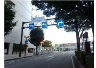
新富町一丁目 2 号門型標識 高さ/6.9m 幅員 12.4m 所在地/新富町地域
