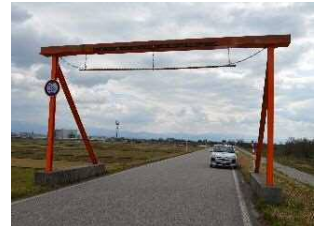
水橋辻ヶ堂 2 号門型標識 高さ/3.8m 幅員 7.0m 所在地/水橋辻ヶ堂地域
