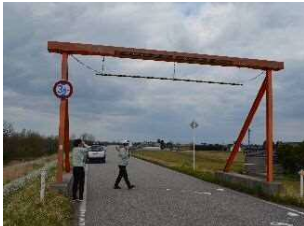
水橋新保 2 号門型標識 高さ/3.8m 幅員 7.0m 所在地/水橋新保地域
