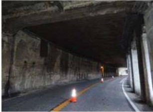
長良谷 5 号洞門 延長/77.0m 幅員 4.7m 所在地/庵谷地域
