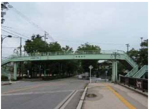
安野屋横断歩道橋 延長/24.5m 幅員 1.9m 所在地/安野屋地域
