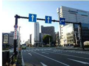
新富町一丁目 1 号門型標識 高さ/6.5m 幅員 9.5m 所在地/新富町地域
