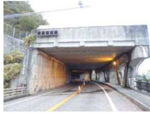
長良谷 2 号洞門 延長/36.0m 幅員 4.7m 所在地/庵谷地域
