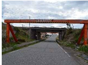
水橋辻ヶ堂 1 号門型標識 高さ/3.8m 幅員 7.0m 所在地/水橋辻ヶ堂地域
