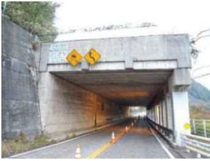
長良谷 1 号洞門 延長/72.0m 幅員 4.7m 所在地/庵谷地域
