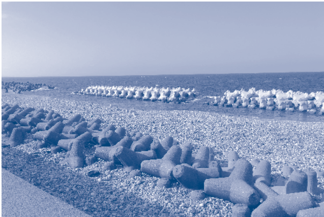
水橋沿岸部の離岸堤
