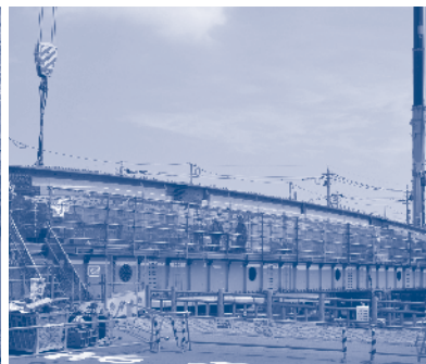
八田橋架替工事の様子（永楽町外地内）
