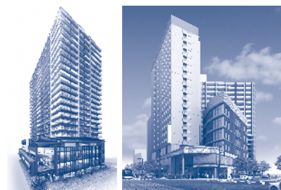
総曲輪三丁目地区市街地再開発 (イメージ) 桜町一丁目4番地区市街地再開発 (イメージ)
