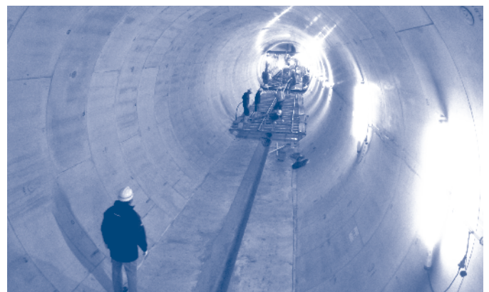
完成した松川雨水貯留施設
