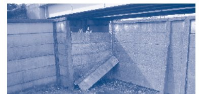
撤去される市所有のブロック塀等
