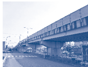
橋脚が補修される開発陸橋（月岡町六丁目外内地内）
