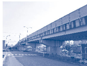
橋脚が補修される開発陸橋（月岡町六丁目外内地内）
