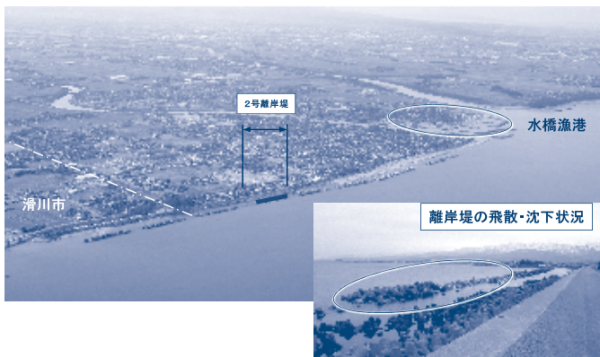
海岸保全施設の改良工事が行われる水橋漁港海岸
