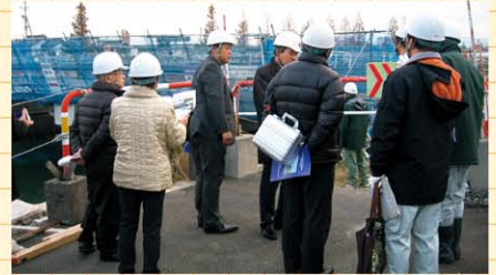
大島橋（下新本町外地内）での視察の様子
