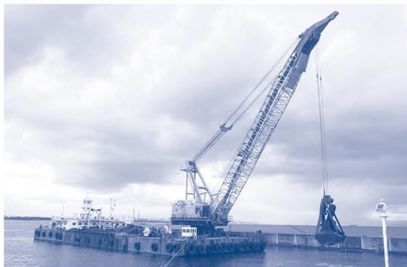
台風19号により被災した四方漁港の航路浚渫（しゅんせつ）工事の様子
