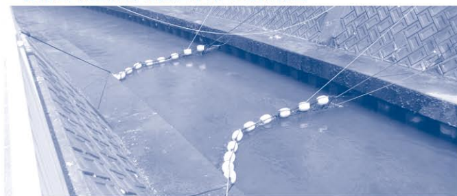
海洋へのごみ流出を抑制するため網場を設置（がめ川）
