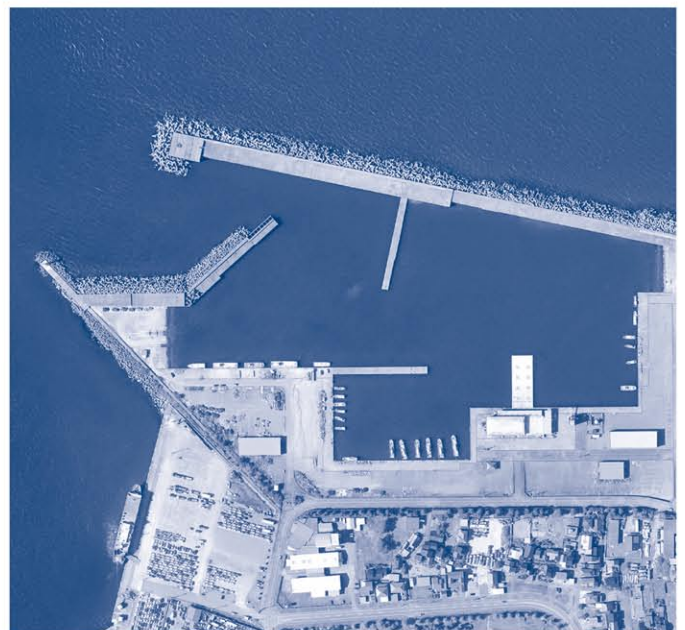
県が管理している岩瀬船だまり
