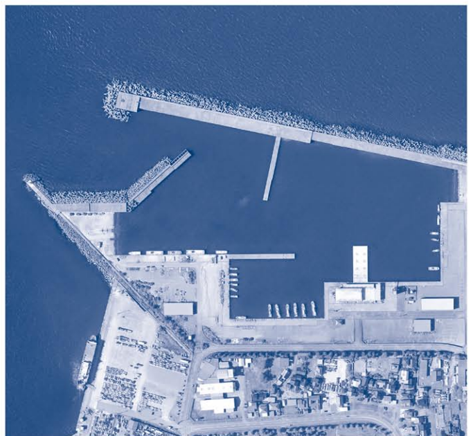
県が管理している岩瀬船だまり
